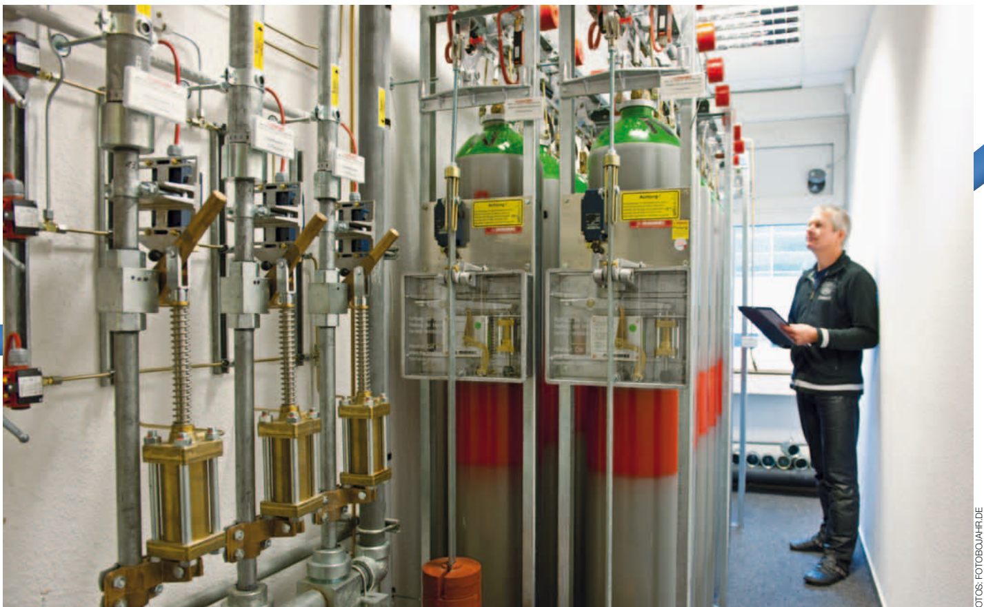
Mit Argon gefüllte Gasflaschen müssen regelmäßig gewogen und kontrolliert werden
