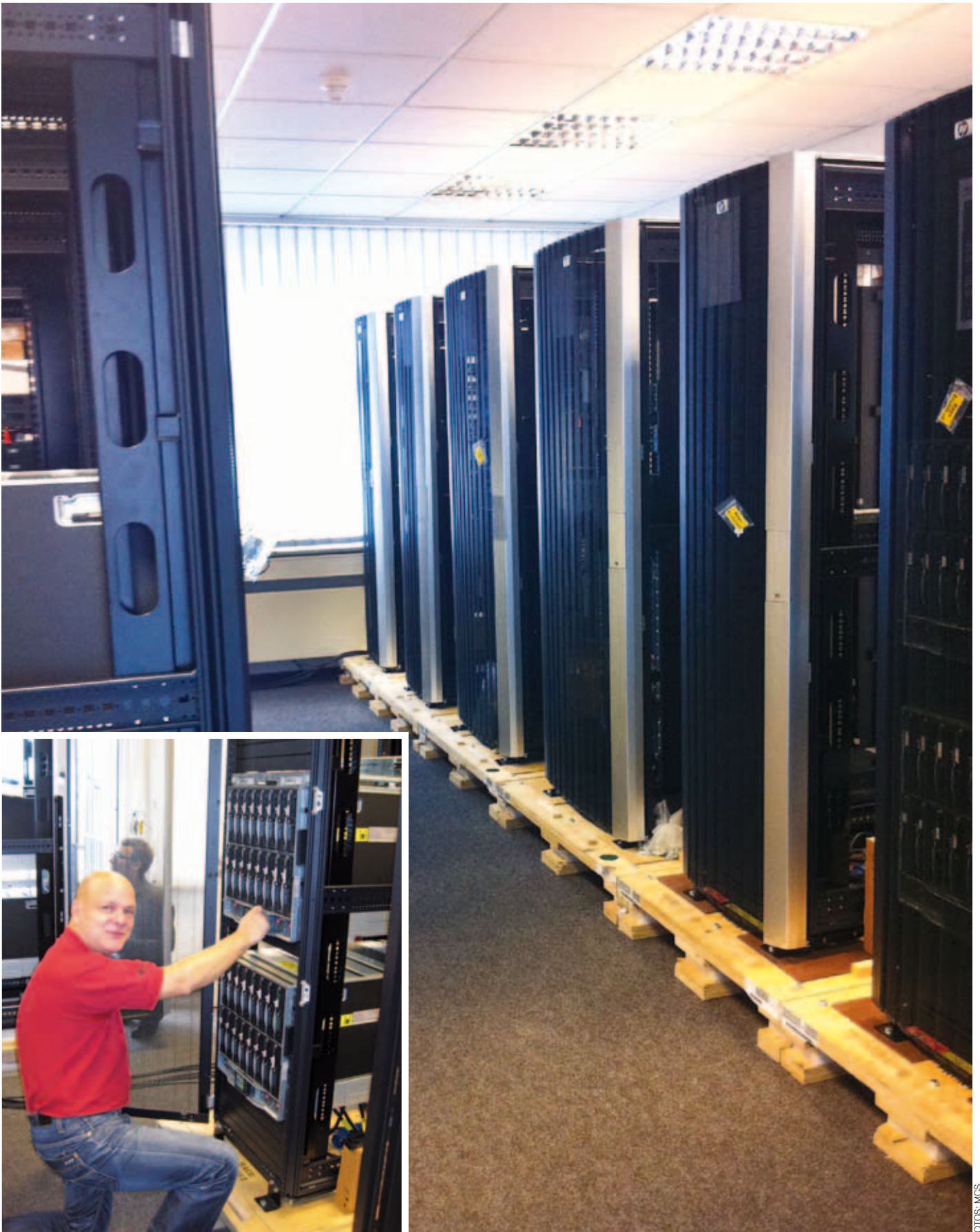
In Rekordzeit wurden die Systeme in Hamburg installiert
